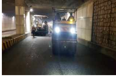
공사 중(절삭 후 포장)
