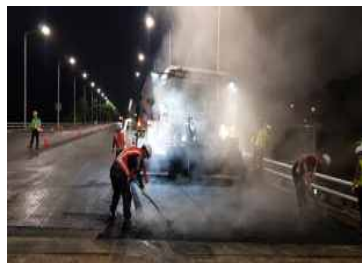
공사 중(교면방수 및 포장)
