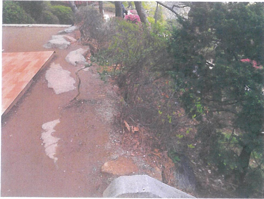
북극보전 정면 석축 (현황 : 조경석 쌓기)
