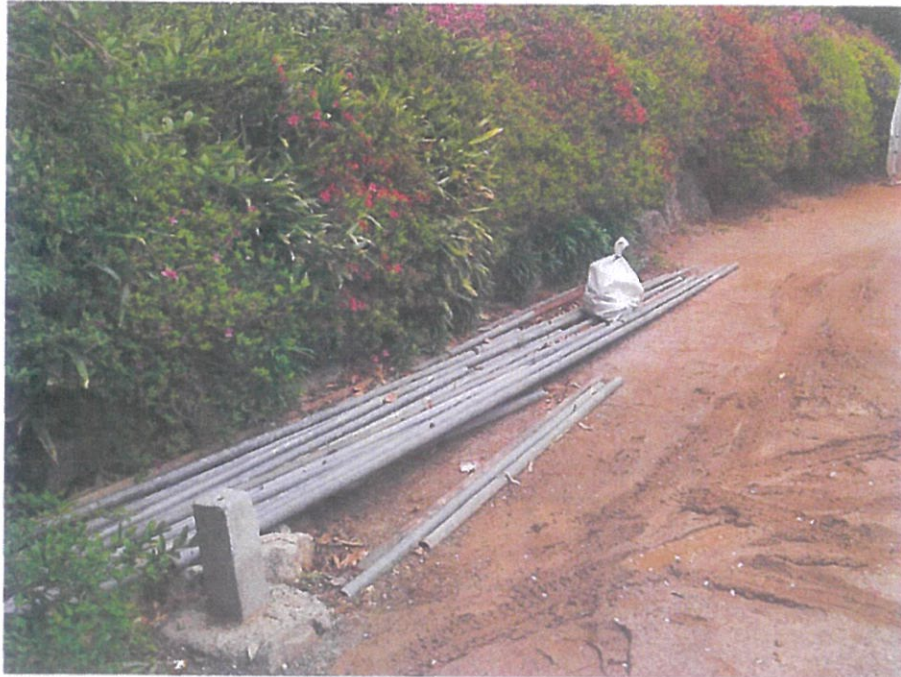
북극보전 배면 석축 (현황 : 조경석 쌓기)
